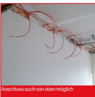
Verteiler zum Heizen und Kühlen
