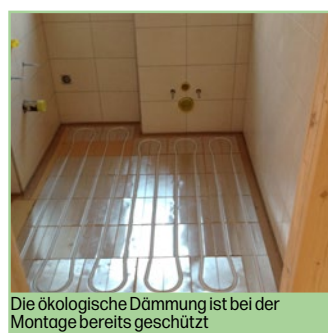
Vollflächiges Aluminiumleitblech
