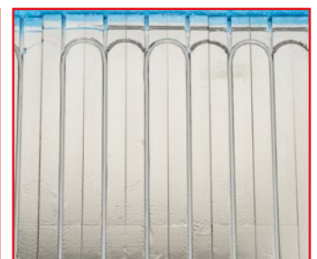
Verlegte Fläche mit Rohrleitungen
