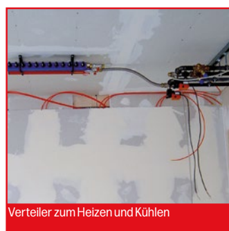
Trockenbau-Wandheizung/-kühlung. Ideal für Dachschrägen
