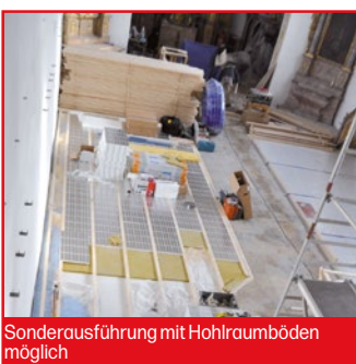
Vollflächiges Aluminiumleitblech
