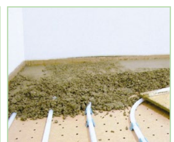
Einbringen des Estriches
