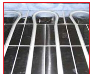
Fertig verlegtes Rohr
