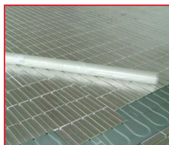
Dämmung ist bei der Montage bereits geschützt
