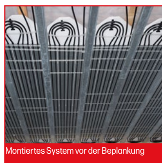
Anschluss der Module
