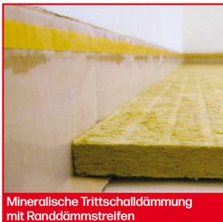
Mineralische Trittschalldämmung mit Randdämmstreifen
