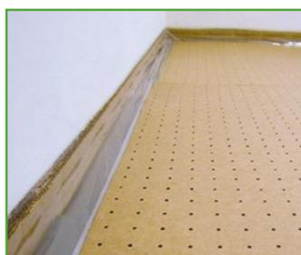
biofaser-Lochplatte® auf Estrichfolie und Trittschalldämmung
