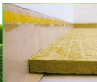
Mineralische Trittschalldämmung mit Öko-Randdämmstreifen
